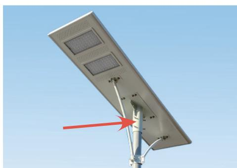
照明をポールに被せてボルトをきつく締めます。取り付け完了です。
