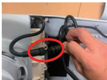
⑥バッテリーの配線を取り外します。
