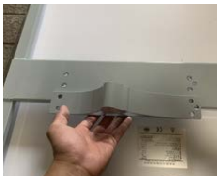
①ソーラーパネルの裏面に金具を取り付けます。
